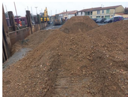
Béton recyclé utilisé comme matériau de remblai.
