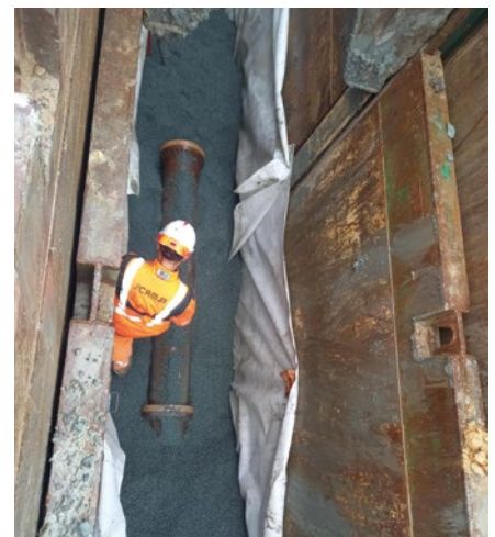
Opérateur au fond d'une tranchée, protégé par un blindage, en train de poser une conduite d'assainissement.
