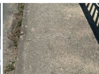
Vue du trottoir béton légèrement fissuré mais globalement en bon état.
