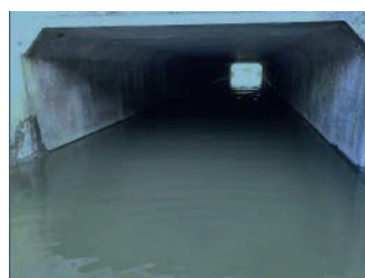
Vue de l'ouvrage constitué de cadres béton armé préfabriqués (environ 80 cm d'eau le jour de la visite).
