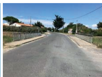
Vue de la voirie sus-jacente en enrobé, des trottoirs béton et garde-corps métallique S8.
