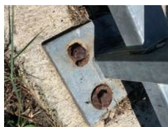
Vue des ancrages de garde-corps en état de corrosion avancée.
