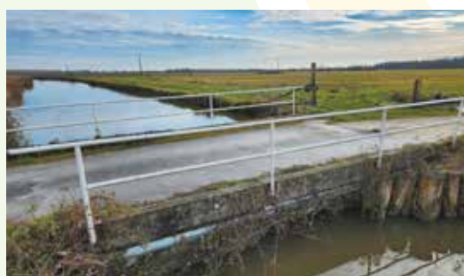
Pont mixte dalle béton / voûte maçonnée Breuil-Magné
