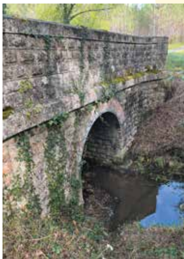
Voûte maçonnée Le Fouilloux
