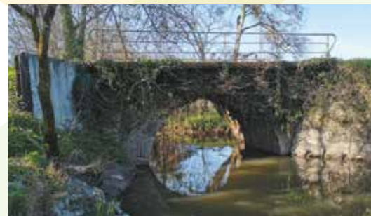
Voûte maçonnée Orignolles / Saint-Martin d'Ary
